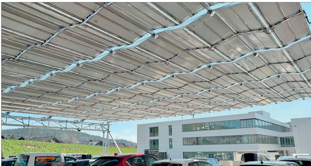
Rund 700 Solarmodule spannen sich in rund sechs Metern Höhe über den Parkplatz. Die gesamte Anlage verfügt über eine Leistung von bis zu 350 kWp
