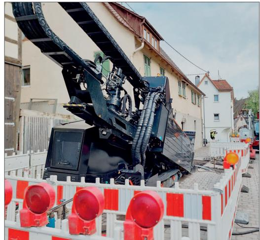
Elektrisches Spülbohrgerät: wurde im Rahmen des Projekts erstmals auf einer realen Baustelle eingesetzt
