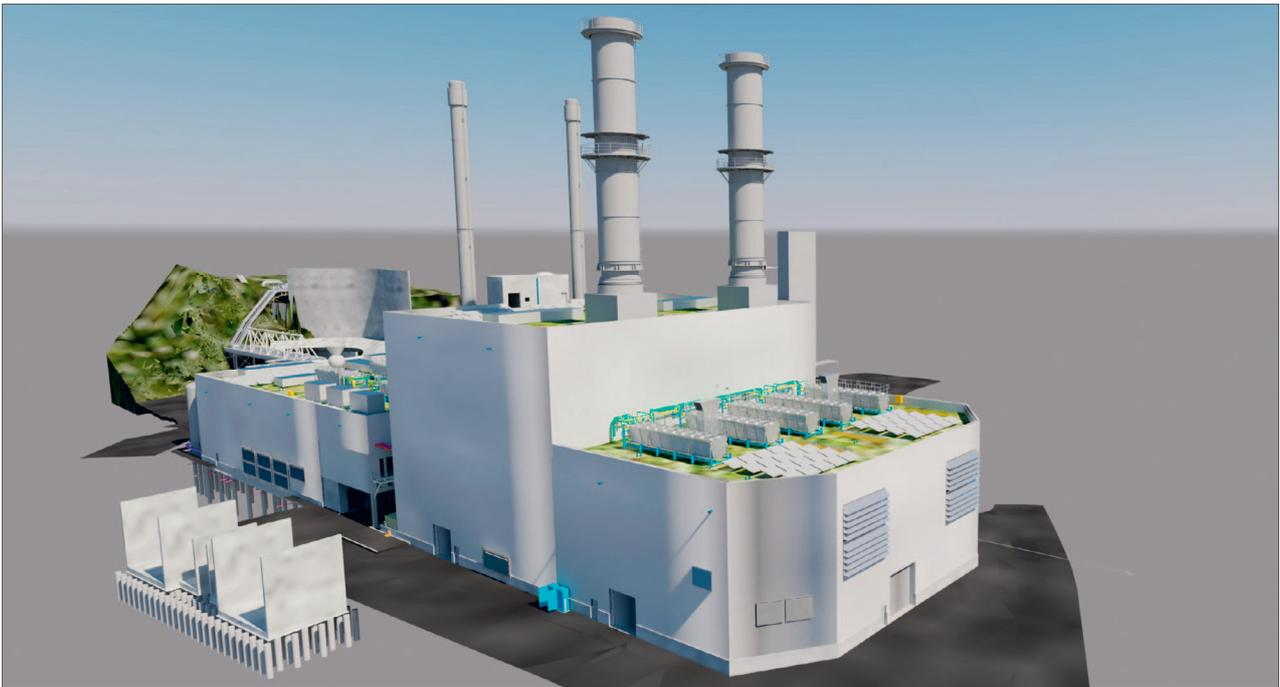
Rendering der Fuel Switch-Anlage (vorne rechts Gasturbinengebäude, hinten links Fernwärmegebäude und Rohrbrücke Nord)
