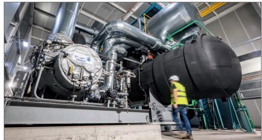
Über die Wärmepumpe wird Fernwärmewasser auf 90 °C Vorlauftemperatur erhitzt. Dabei nutzt sie als Wärmequelle das durch die Dampfturbinen-Kondensatoren erwärmte Kühlwasser vor seiner Wiedereinleitung in den Neckar. Dabei wird unter üblichen Betriebsbedingungen trotz der hohen Vorlauftemperatur ein COP von ca. drei erreicht.
