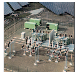
Batteriepufferung neben PV-Freiflächenanlage © EnBW
