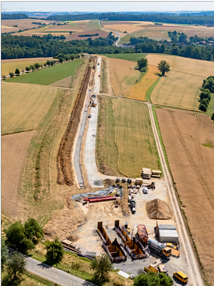
Luftaufnahme eines Bauabschnitts mit offener Bauweise bei Herksbach, Niedersachsen ©TransnetBW
