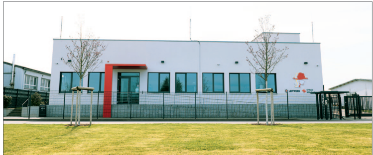
Rechenzentrum Appenweier Quelle: E-Werk Mittelbaden
