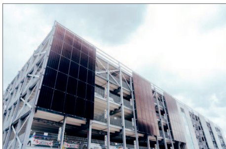
Parkhaus des EnergieCampus Quelle: Stadtwerke Stuttgart
