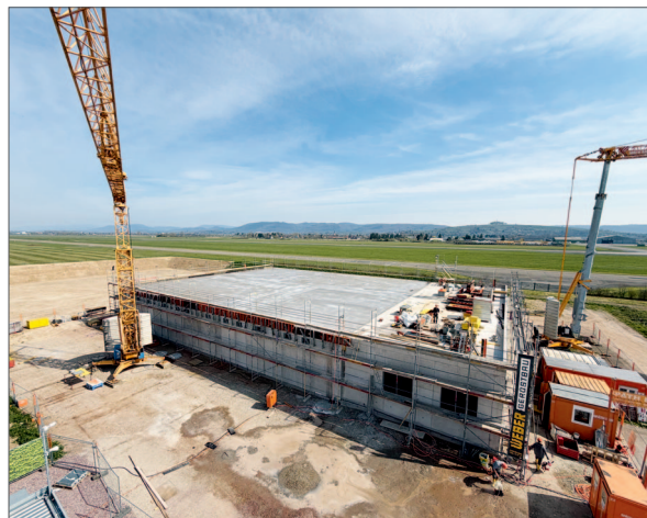
Rechenzentrum Lahr im Bau Quelle: E-Werk Mittelbaden
