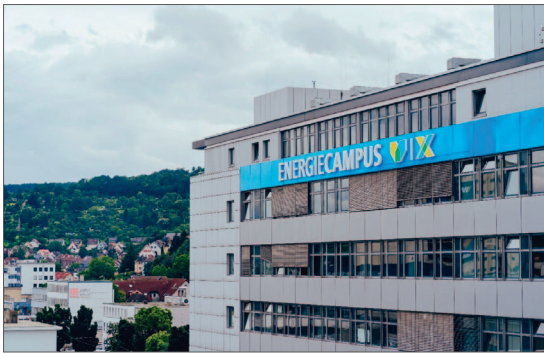
EnergieCampus der Stadtwerke Stuttgart Quelle: Stadtwerke Stuttgart
