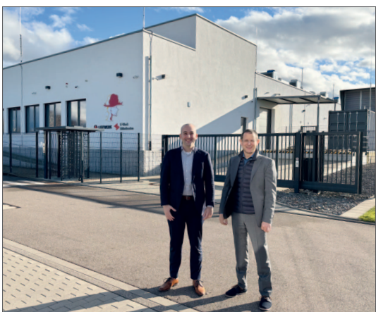
Julian Neunstöcklin und Ralf Schaufler, Geschäftsführer LEITWERK Rechenzentren Appenweiler/Lahr GmbH Quelle: E-Werk Mittelbaden
