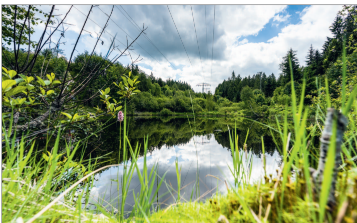
Hochspannungstrasse Quelle: Netze BW GmbH
